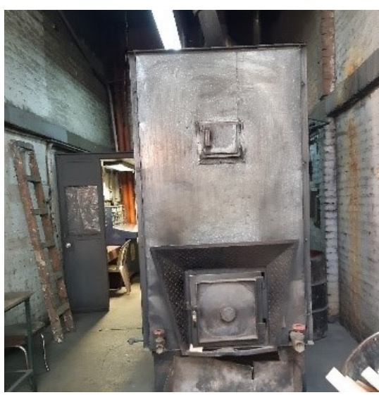
Fotografía 2. Caldera marca Dynaterm de 70 BHP
